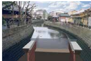
Jドメール® による河川改修
