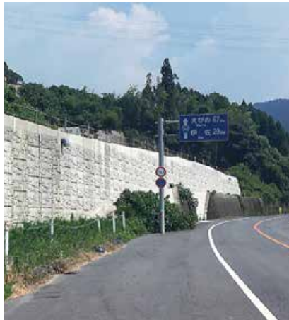
テールアルメ FS 施工例
