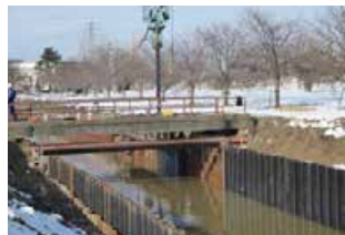
軽量鋼矢板による水路
