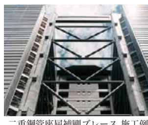
二重鋼管座屈補剛ブレース 施工例
