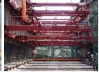
Ecoラム® 工法 道路函渠工事
