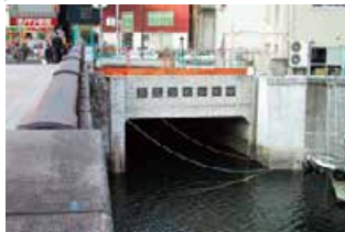
Jドメール® 分水路施工例
