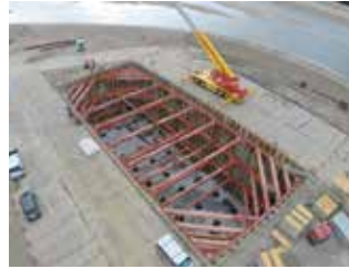
Ecoラム® 工法 橋脚基礎工事
