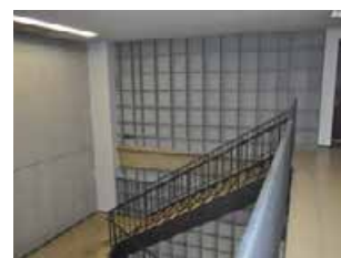
制振壁 施工例
