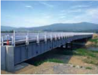
仮設橋梁 施工実績
