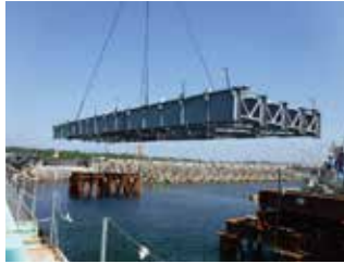
仮設橋梁 施工状況
